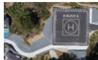
上ノ加江ヘリポート整備工事 (中土佐町役場)
