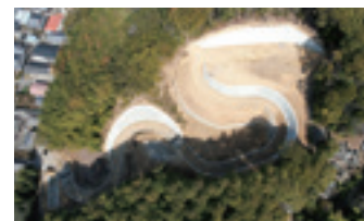
第1水源配水池更新工事に伴う 進入路設置工事 (香南市役所)
