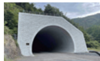
国道441号防災安全交付金 (口屋内トンネル(II))工事 (高知県幡多土木事務所)
